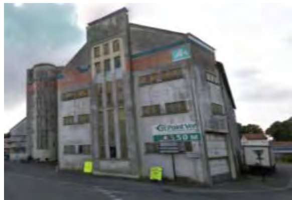
Silo à céréales d'Achiet-le-Grand
