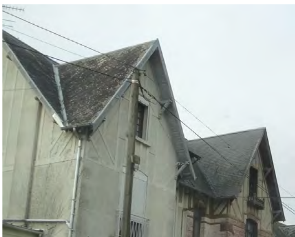
Le niveau supérieur en bois et torchis, le colombage est apparent
