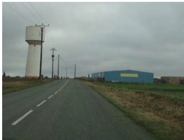
Figure 17 : Château d'eau et hangar agricole à Villers-au-Flos
