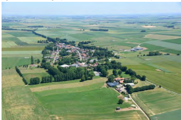
Figure 46 : Photographie aérienne-Ville de Martinpuich
