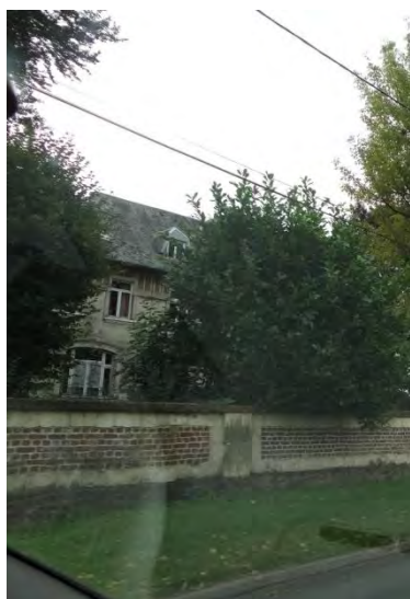
Mur en craie et brique, habitation en craie à l'arrière plan
